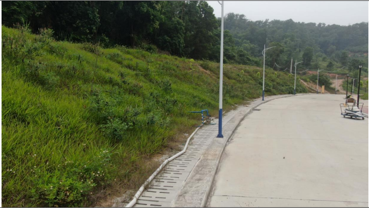
位 置：环校路 K0+460~K0+600 现场情况：沿环校路设置排洪渠。
