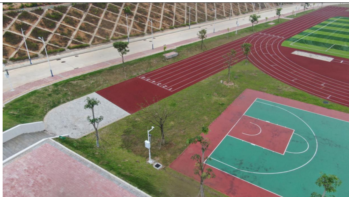
位 置：体育运动场片区 现场情况：体育运动场周边完成景观绿化恢复。
