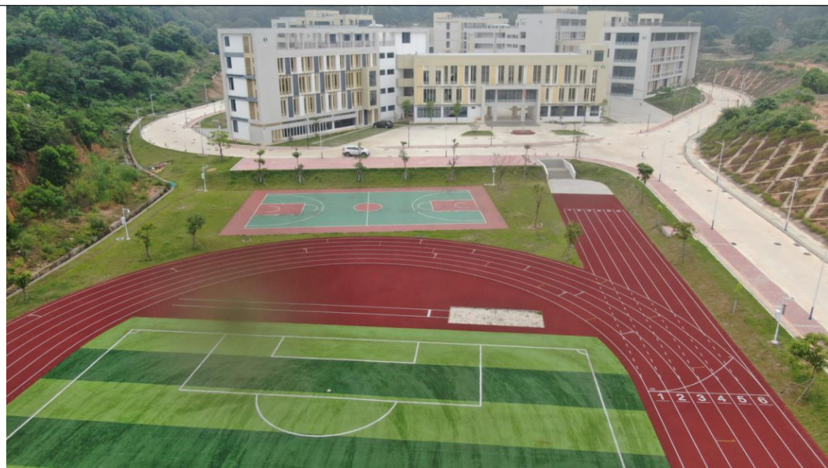
位 置：体育运动场片区 现场情况：完成橡胶场地铺设。
