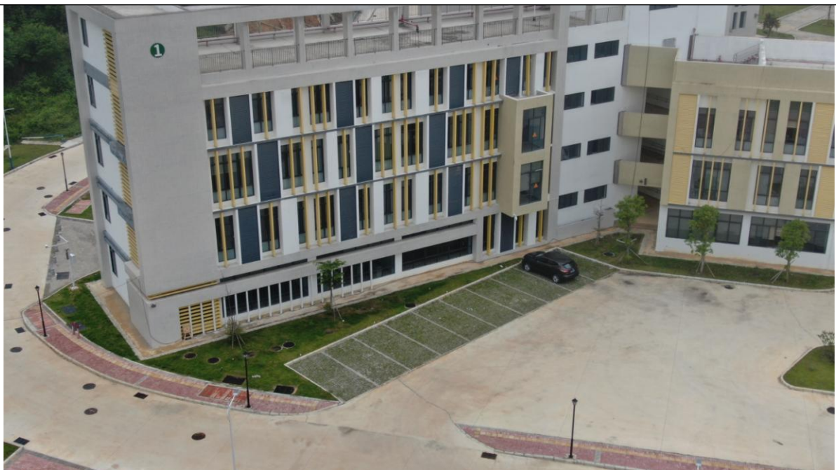
位 置：G-1#楼 现场情况：1#教学办公楼周边景观绿化区实施景观绿化工程。
